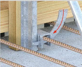
Winkel mit Strebe ausrichten und mit Bogenkeil an unterer Armierung verkeilen.
