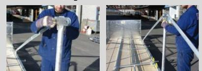
Aufklappen der Seitenschutzgeländer. Die Sicherung erfolgt automatisch durch das Herunterfallen der Fallkeile und muss überprüft werden. Für den Vorgang sind 2 Personen erforderlich.
