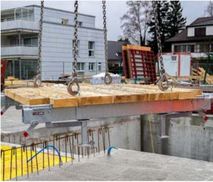
Die Lift-Plattform steht zum Lagern auf 4 bzw. 6 Füßen und lässt sich platzsparend stapeln. Sie lässt sich mit dem Baukran dank den 4 Anschlagpunkten optimal versetzen
