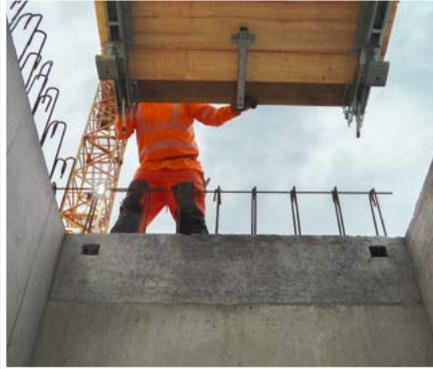
Das erste Einführen in den Liftschacht erfolgt von oben, anschliessend wird sie jeweils zeitsparend in die nächste Etage nachgezogen
