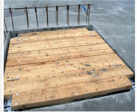
Der Liftschacht ist sicher verschlossen und ermöglicht das Auflegen von Decken- und Wandschalungen
