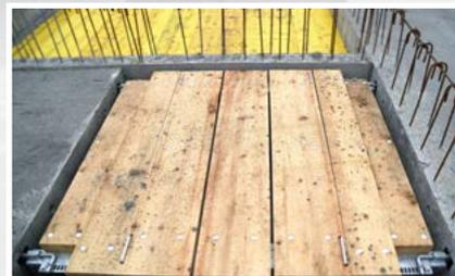
Die Lift-Plattform ermöglicht das rationale Sichern von Liftschachtöffnungen
