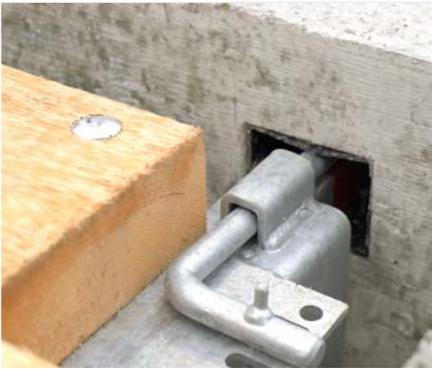
Zusätzlich zum automatischen Einhängen sichert der Sicherungsbolzen die Lift-Plattform vor dem Verschieben
