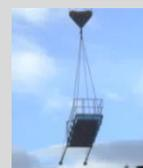
Einführen der MS-Plattform Extrem 2000 durch eine mit PSAGa gesicherte Person.
