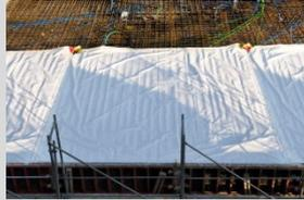
Wenn die Blache gefüllt ist, mit Schnee oder Schüttgut, kann die Blache an den vier gelben Anhängeschlaufen angeschlagen werden und an gewünschten Ort transportiert werden.
