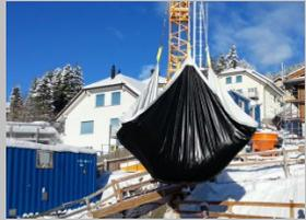
Beim Entladen der Blache von Schnee oder Schüttgut sind zwei Anhängeschlaufen von dem Kranhaken zu lösen und die Blache kann mit dem Kran weggezogen werden.
