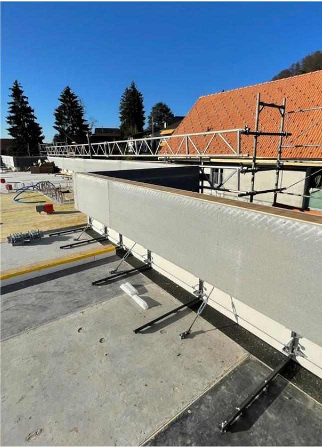
Die Deckenwinkel können stufenlos verschoben werden um Anschlusseisen und Einlagen auszuweichen
