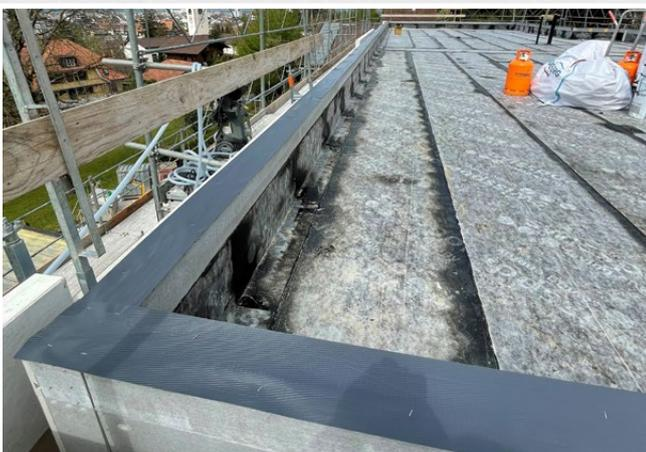
*Die Dampfbremse kann einfach ans Dachkranzelement geklebt oder geschweisst werden*
