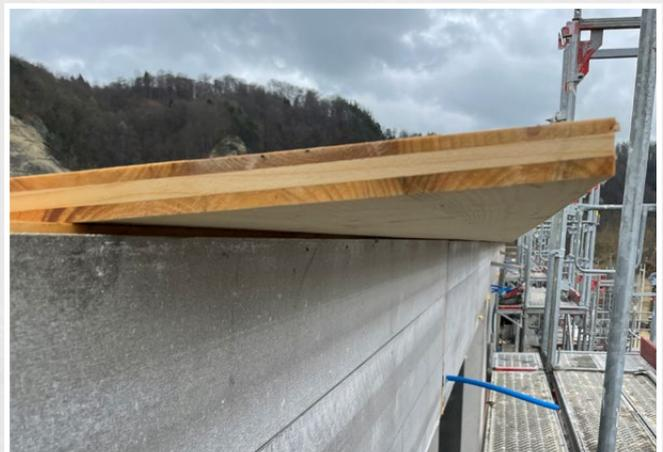
*Ein Brüstungsabdeckbrett lässt sich mit 4° Innengefälle direkt auf das Bordfix Dachkranzelement aufschrauben*
