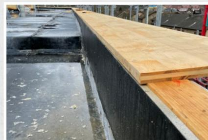
Die Dampfbremse und die Flachdachabdichtung kann optimal auf das Dachkranzelement abgedichtet werden
