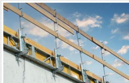
Deckenrandabschalung mit Maxi-Form und BKA Pro Konsole 30 cm sowie einem Seitenschutz mit Steckpfosten und Holzlaten
