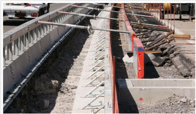
Maxi-Form im Strassenbau auf Beton aufgeschraubt
