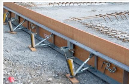
Bodenplattenabschalung mit Maxi-Form
