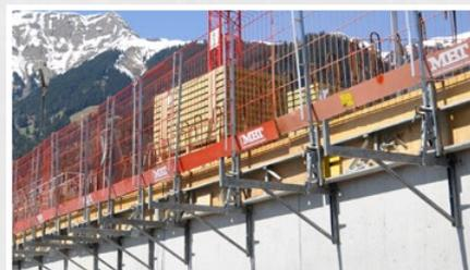
Deckenrandabschalung mit Maxi-Form und BKA Pro Konsole 100 cm sowie einem Seitenschutz mit Safe-Gard
