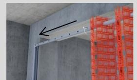
Öffnungsrichtung der Swing-Door mit umstellen des Drehlagers.
