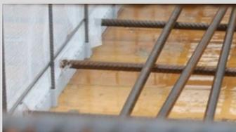
Die obere Armierung zwischen der Kunststoffleiste und dem Quereisen durchstossen.
