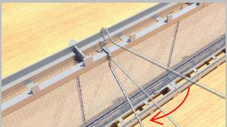
Das Net-Form in der Vertikalen ausrichten und die Zuglaschen auf die Schalung aufnageln.
