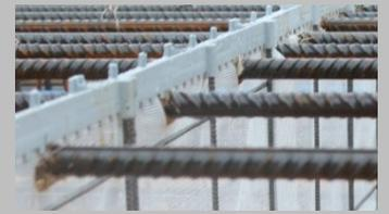
Je nach Einbringen des Betons wird empfohlen ab einer Deckenstärke von 36 cm alle 1.5 m BPA Bodenplattenabschalung oder Leibungsschalungswinkel zur Aussteifung des Net-Forms zu montieren.
