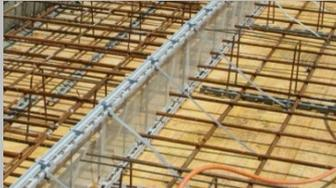
Die untere Armierung ist oberhalb der Kunststoffleiste durchzustossen.
