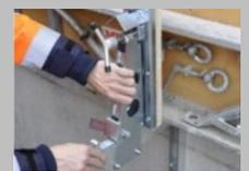
Querkeil des Schlittens mit einem Hammer festziehen.
