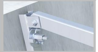
Es ist zu überprüfen, dass die Konsole vertikal ausgerichtet ist und die gegenseitigen Konsolenabstände eingehalten sind.
