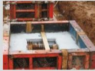
Grössere TBA Aussparung als Innen oder Aussenschalung sind mit konventionellen Mitteln auszusteuern. Ab welcher Aussparungsgrösse ausgesteift werden muss ist unter Punkt «Technische Daten - Aussteifungsdiagramm» nachzusehen.
