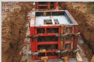
TBA Aussparung einbetoniert als Innenschalung / Aussparung.
