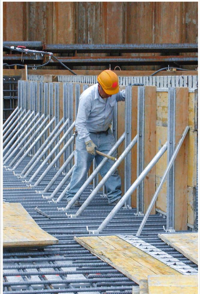
Abschalstützen AST-SK bei der Montage
