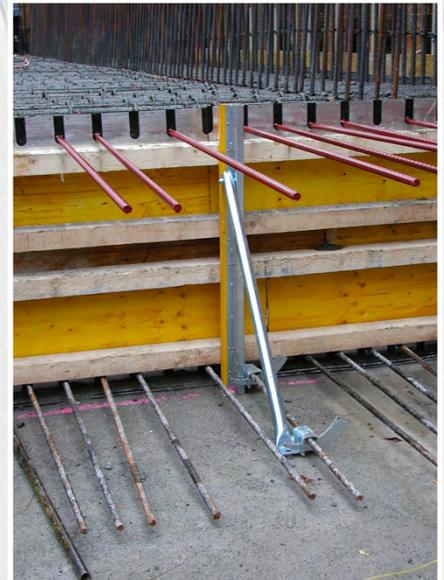
Abschalstütze AST SK befestigt am unteren Armierungseisen...
