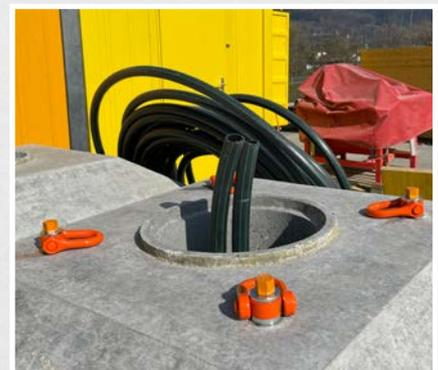
Einzel, im Doppel oder zu Viert ist der Anschlagwirbel 360° für hohe Lasten ausgelegt
