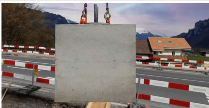
Der Anschlagwirbel 360° ermöglicht einen sicheren Transport von Betonelementen
